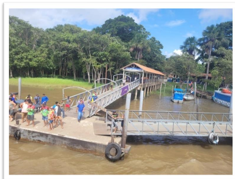
Fotografia 3 – Terminal Hidroviário Antônio Tavernard
